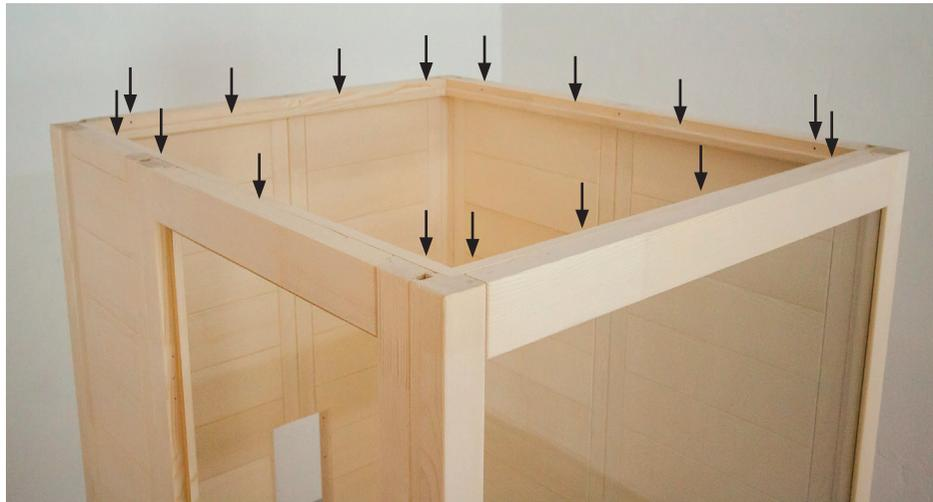
**Abb. 13: Einlegen Dachelement hinten mit Lüfterausschnitt**
