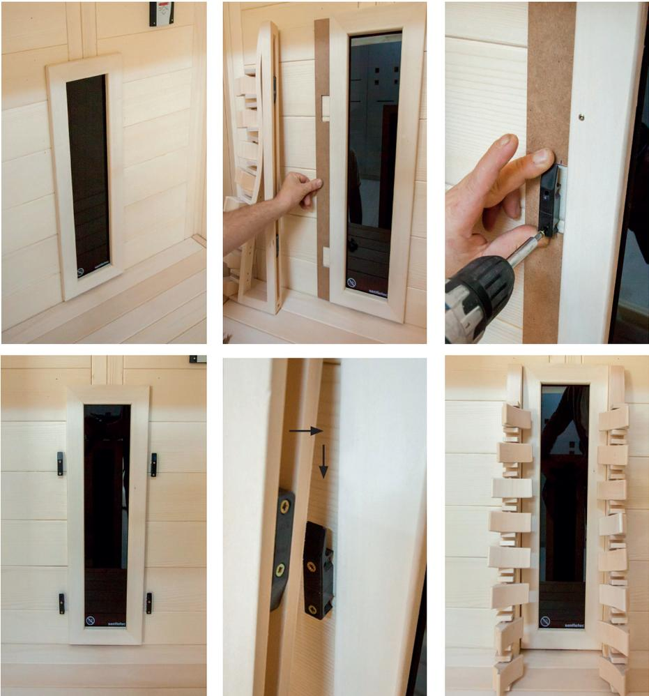
Stecken Sie abschließend die Rückenlehnen von oben nach unten auf die Halterungen bis diese einrasten.
