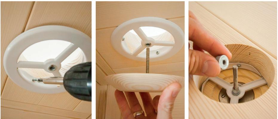
Schrauben Sie das Basiselement der Entlüftung mit den 3 beiliegenden Schrauben fest. Schrauben Sie anschließend das Holztafel ein und sichern Sie die Schraube von außen mit der Kunststoffkappe.
