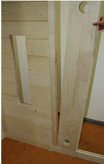
Abb. 6: Elektroelement einsetzen
