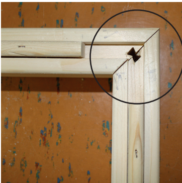
Abb. 2: Bodenelemente verbinden
