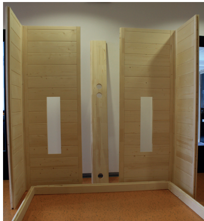
Abb. 5: Montage auf Bodenrahmen
