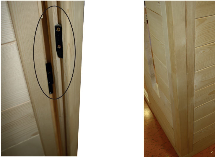
Abb. 4: Wandelemente mit Ecksteher verbinden
