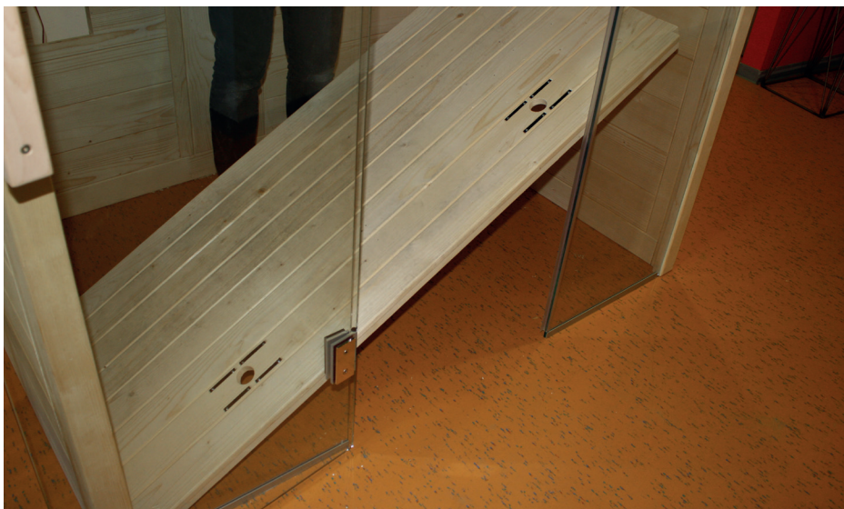
Abb. 28: Kabinenboden einlegen
