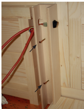
Abb. 33: Montage der U-Leisten für Wärmeplatten
