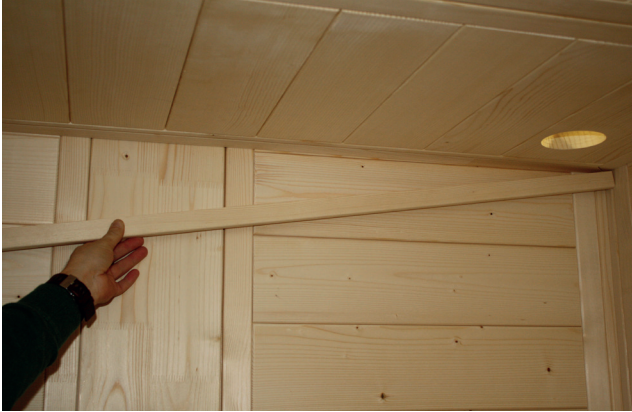
Abb. 37: Montage der LED-Abdeckleiste
