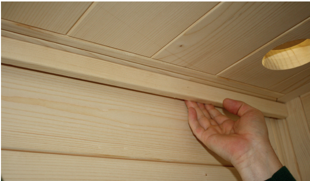
Abb. 38: Einkleben des LED Stripes
