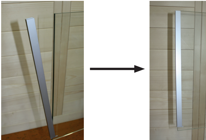
Abb. 11: U-Profile an den Glasplatten anbringen
