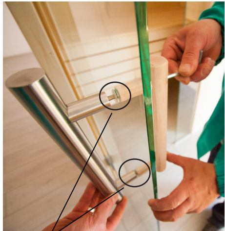
Kunststoff Beilagscheibe bei Niro-Griff beilegen
