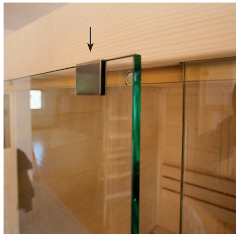
Kunststoff-Beilagscheiben bei Niro-Griff beilegen
