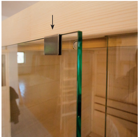
Kunststoff-Beilagscheiben bei Niro-Griff beilegen
